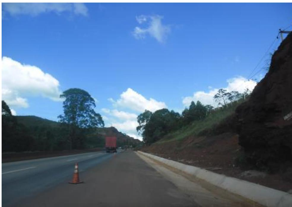
*Figura 02 – Valeta de proteção de aterro concluída*
