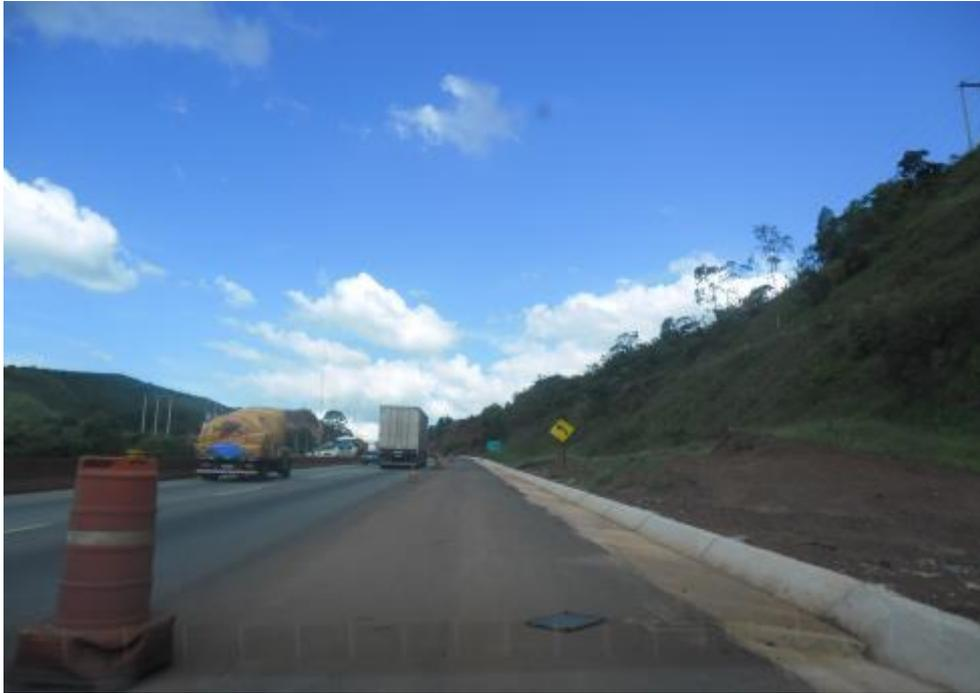
*Figura 03 – Valeta de proteção de aterro concluída*
