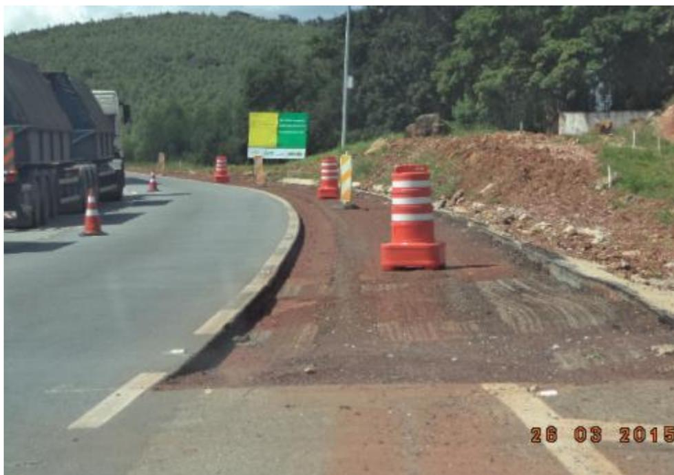
*Figura 01 – Fresagem do pavimento existente*
