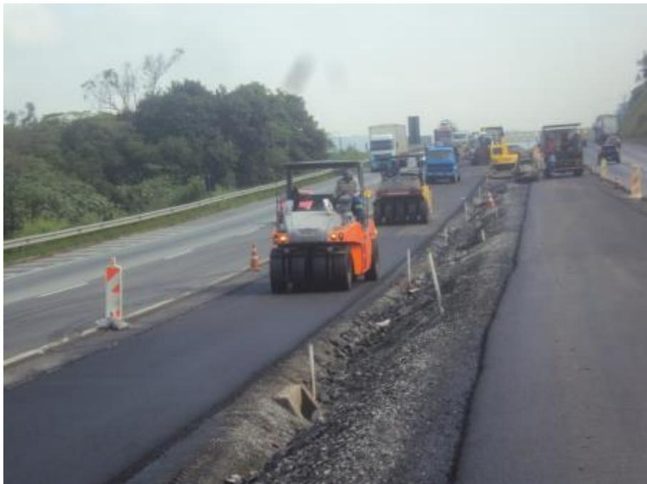
*Figura 04 – Aplicação da camada de Binder e capa - Km 44*
