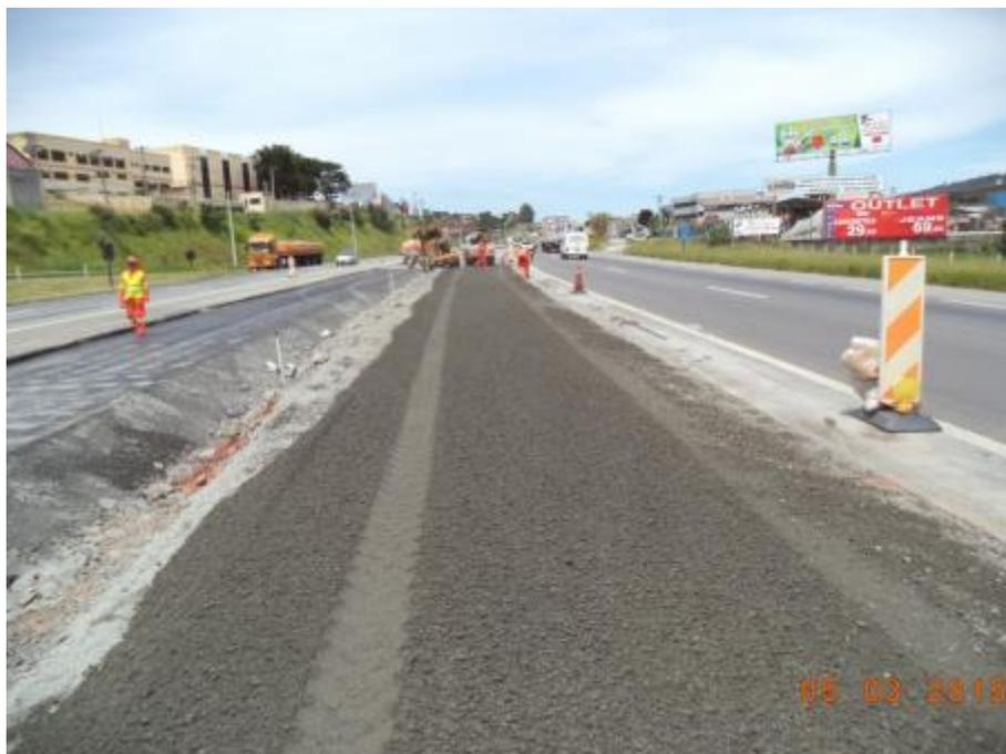
*Figura 01 – Aplicação e compactação da camada BGTC - Km 44,120*
