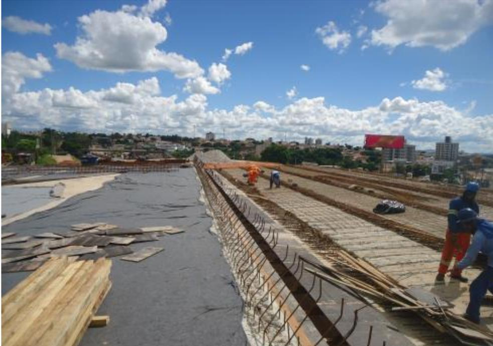
*Figura 01 – Protensão das vigas longarinas*
