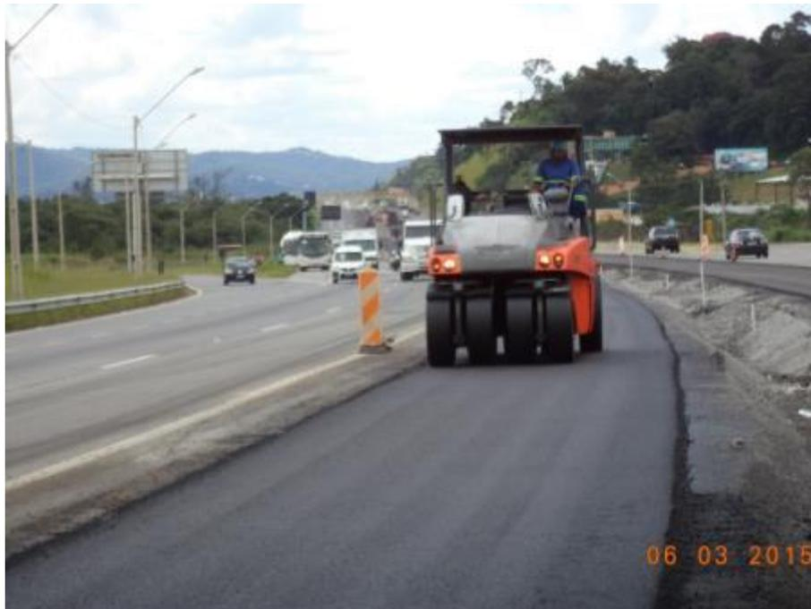
*Figura 05 – Aplicação da camada de Binder e capa - Km 44*
