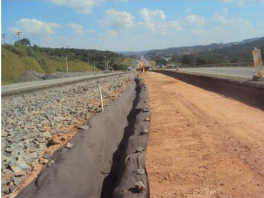
*Figura 05 – Execução de dreno longitudinal - Km 45*
