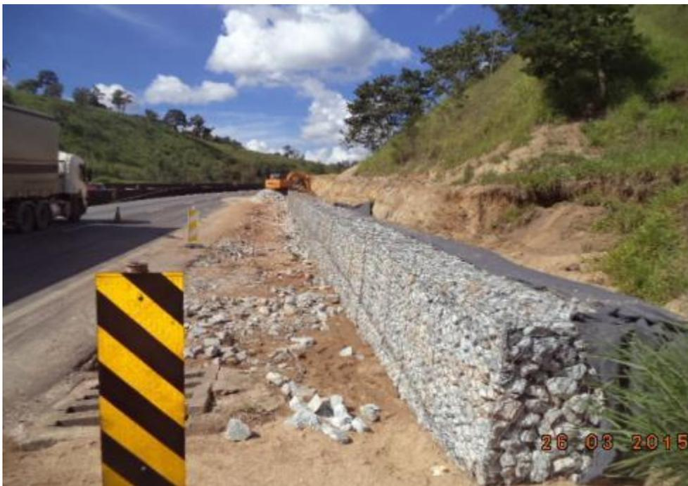
*Figura 06 – Execução de muro gabião*
