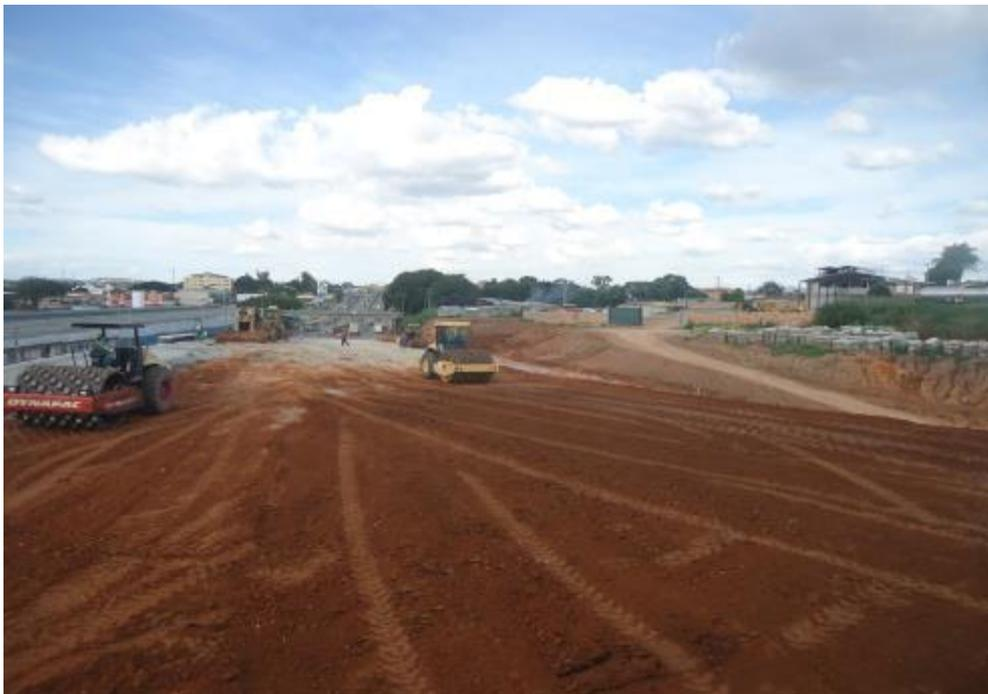
*Figura 04 – Compactação de camada de aterro*
