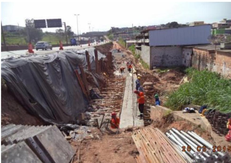
*Figura 04 – Execução de muro*
