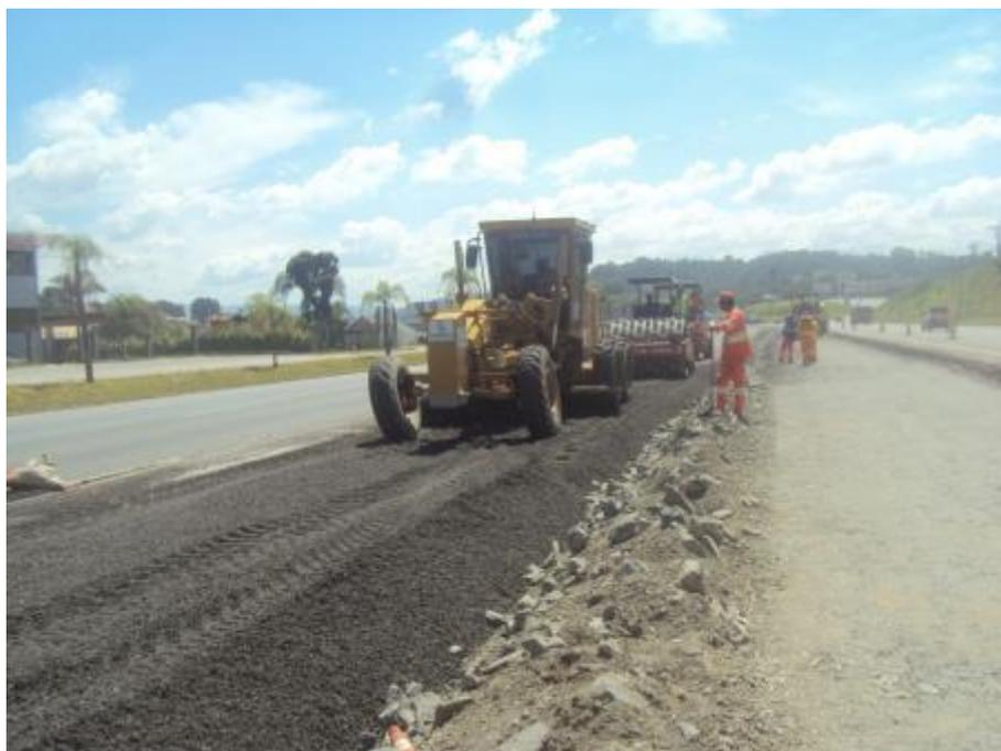
*Figura 02 – Aplicação e compactação da camada BGTC - Km 44,120*
