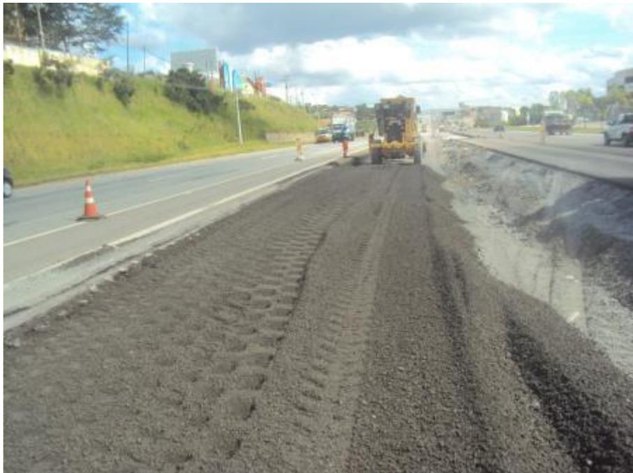
*Figura 04 – Aplicação da camada BGTC - Km 44*
