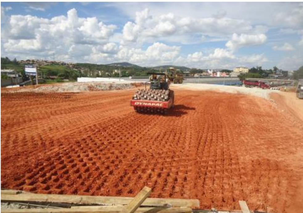
*Figura 02 – Compactação de camada de aterro*
