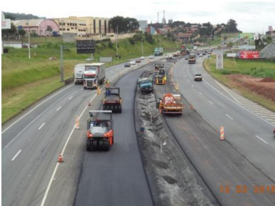
*Figura 06 – Aplicação da camada de Binder e capa - Km 43,890*
