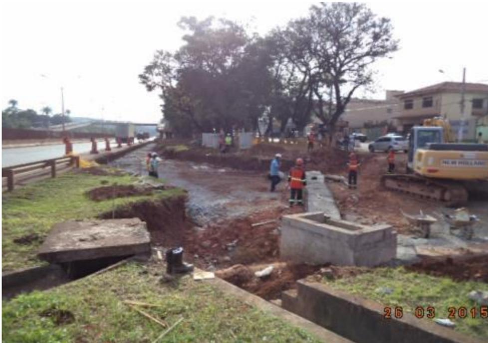
*Figura 06 – Execução de caixa coletora*
