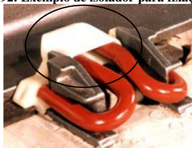
Figura 192: Exemplo de isolador para fixação lateral
