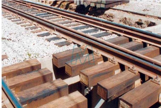
Figura 147: Exemplo de dormente de madeira para pontes
