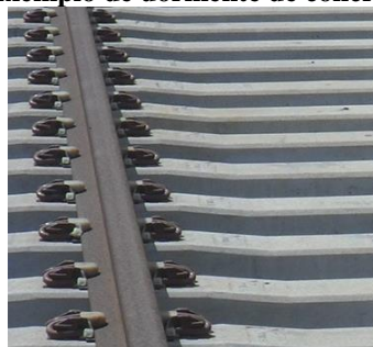
Figura 143: Exemplo de dormente de concreto monobloco
