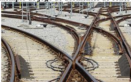
Figura 196: Exemplo de jogo de dormentes de concreto para AMV
