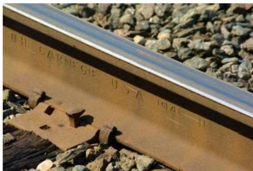
Figura 308: Exemplo de retensor de linha para TR37
