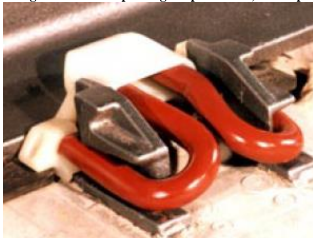
Figura 184: Exemplo de grampo elástico, fast clip
