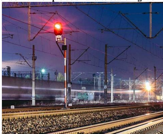
Figura 321: Exemplo de sinal alto searchlight unifocal
