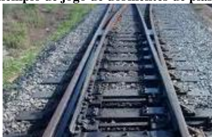
Figura 197: Exemplo de jogo de dormentes de plástico para AMV
