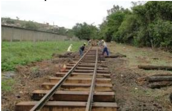
Figura 145: Exemplo de dormente de madeira de 1ª categoria
