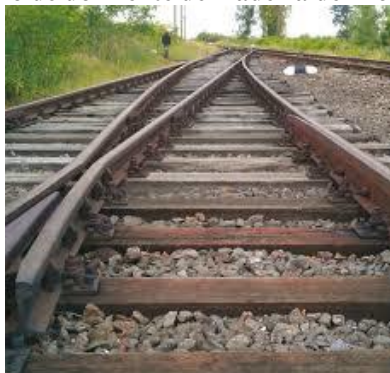
Figura 146: Exemplo de dormente de madeira de 1ª categoria, para AMV
