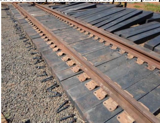
Figura 148: Exemplo de dormente de plástico para pontes
