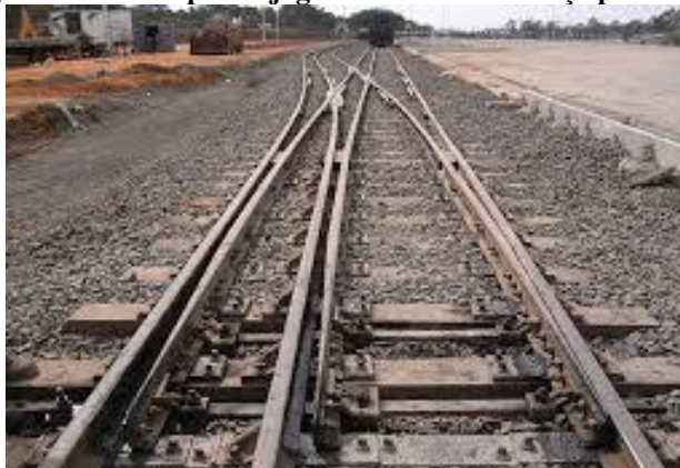
Figura 195: Exemplo de jogo de dormentes de aço para AMV
