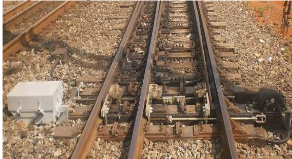
Figura 226: Exemplo de máquina de chave eletro-hidráulica, modelo MD-2000
