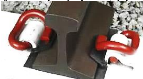
Figura 182: Exemplo de grampo elástico, tipo pandrol
